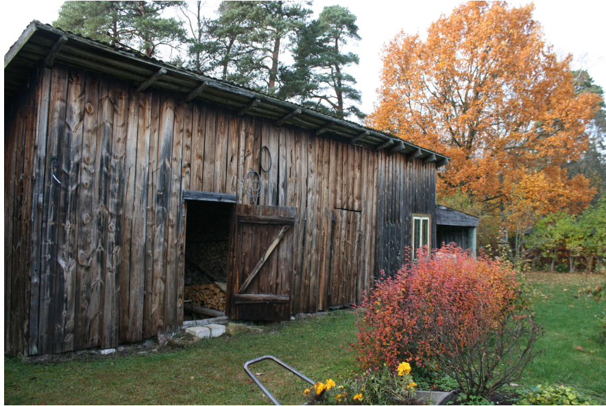
Foto 3. Lammutamisele kuuluv kuur Rahvamaja tee 12 kinnistu loodeosas. Vaade loode suunas
