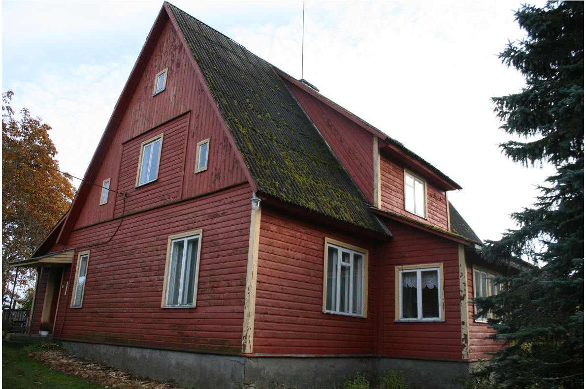
Foto 1. Kahekorruseline puitelamu Rahvamaja tee 12 kinnistul. Vaade hoone loodenurgast
